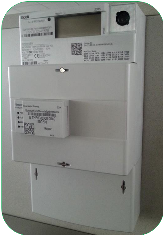
Bild 46: Zähler mit SMGW, Moduldeckel und Klemmenblockdeckel
