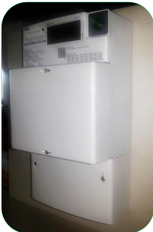
Bild 38: Moduldeckel abnehmen
