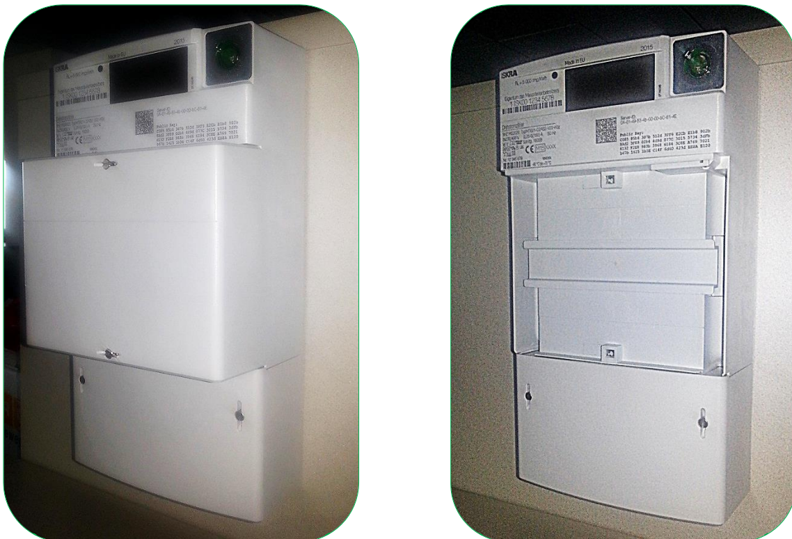
Bild 38: Moduldeckel abnehmen
