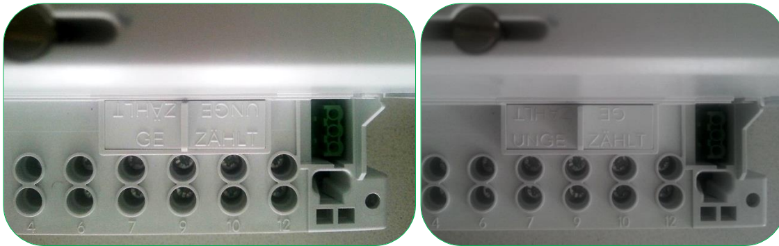
Bild 50: Sicherungsgehäuse in richtiger Position – Stellungen "GEZÄHLT" (links) und "UNGEZÄHLT" (rechts)
